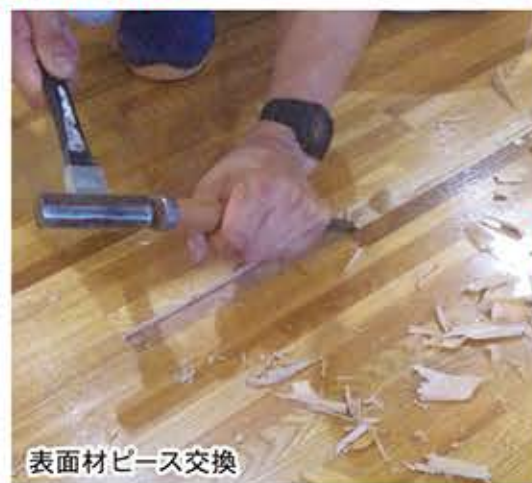
【補修方法】破損材の撤去
