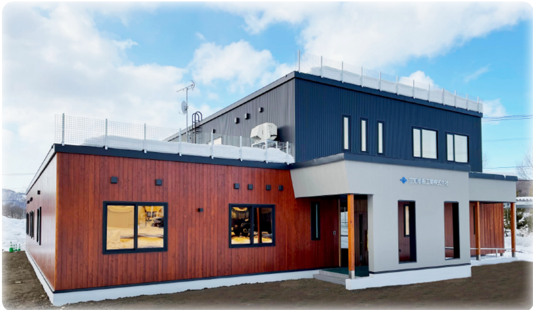
令和 4 年 2 月 竣工
